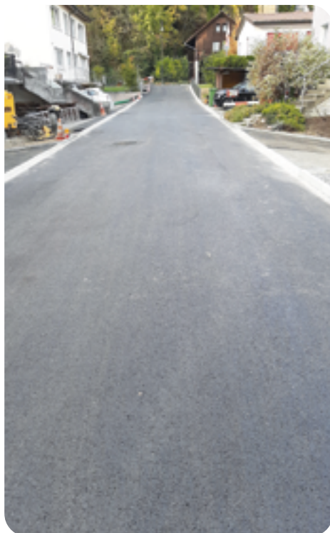
Sanierung Auweg nachher
