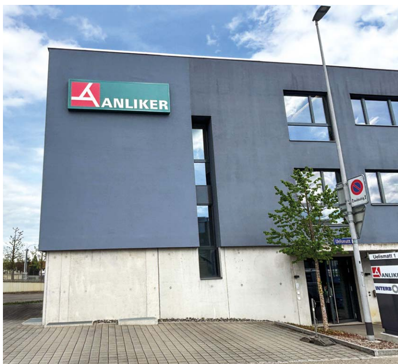
Das Bürogebäude von ANLIKER in Rickenbach.
